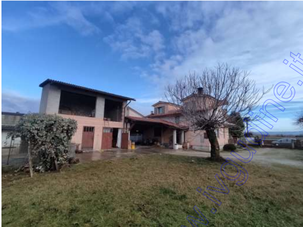
Porticato – deposito/granaio e porcilaie – vista da Sud
