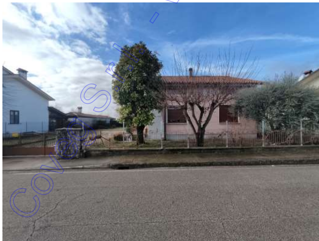
Vista Est lato strada
